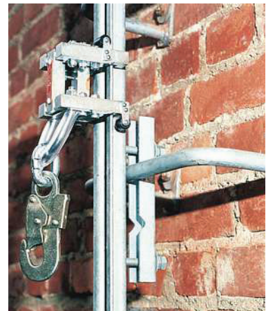
Befestigung der Fallschutzschienen mittig auf den Steigeisen
